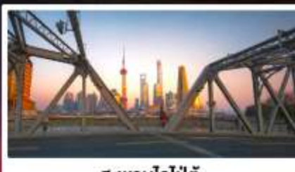
สะพานไวปี้ดู่
