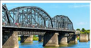
สะพานหวาดถานตง
